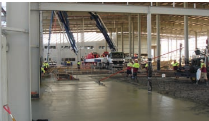
Large warehouse concrete floor slab pour
